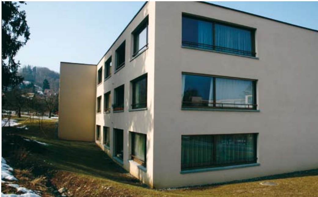
Die Pflegewohnung befindet sich im Parterre am Hagenbuchrain 10. Die preisgekrönte Neubauesiedlung in Zürich Albisrieden gehört der Baugenossenschaft Sonnengarten.
